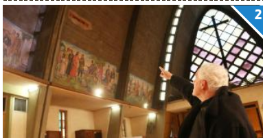
SAN POLO. La chiesa della Conversione di San Paolo a San Polo Vecchio come per San Giacinto a Lamarmora è stata dichiarata inagibile per cedimenti strutturali che si manifestano sulla facciata e nelle navate
