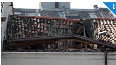
SAN GIACINTO. La chiesa ha meno di 70 anni, eppure il tetto si è pericolosamente imbarcato da richiederne l'interdizione. Il parroco ha preso contatti con ingegneri e architetti per la predisposizione di un progetto
